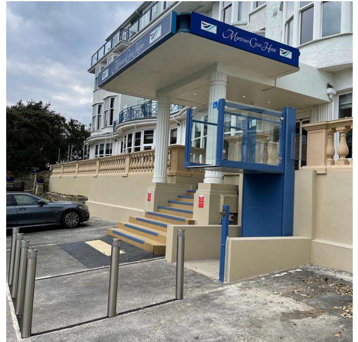
Приклади облаштування вертикального підйомника на прилеглій території
