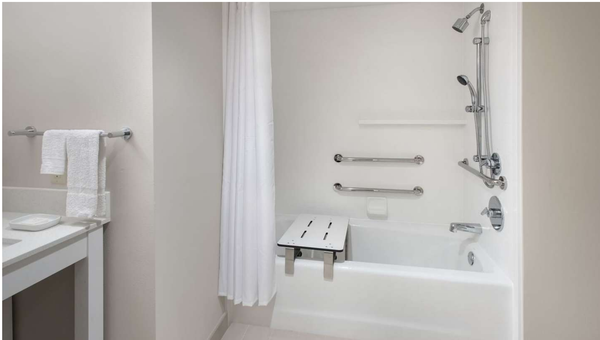
Приклад облаштування ванної з портативним сидінням
